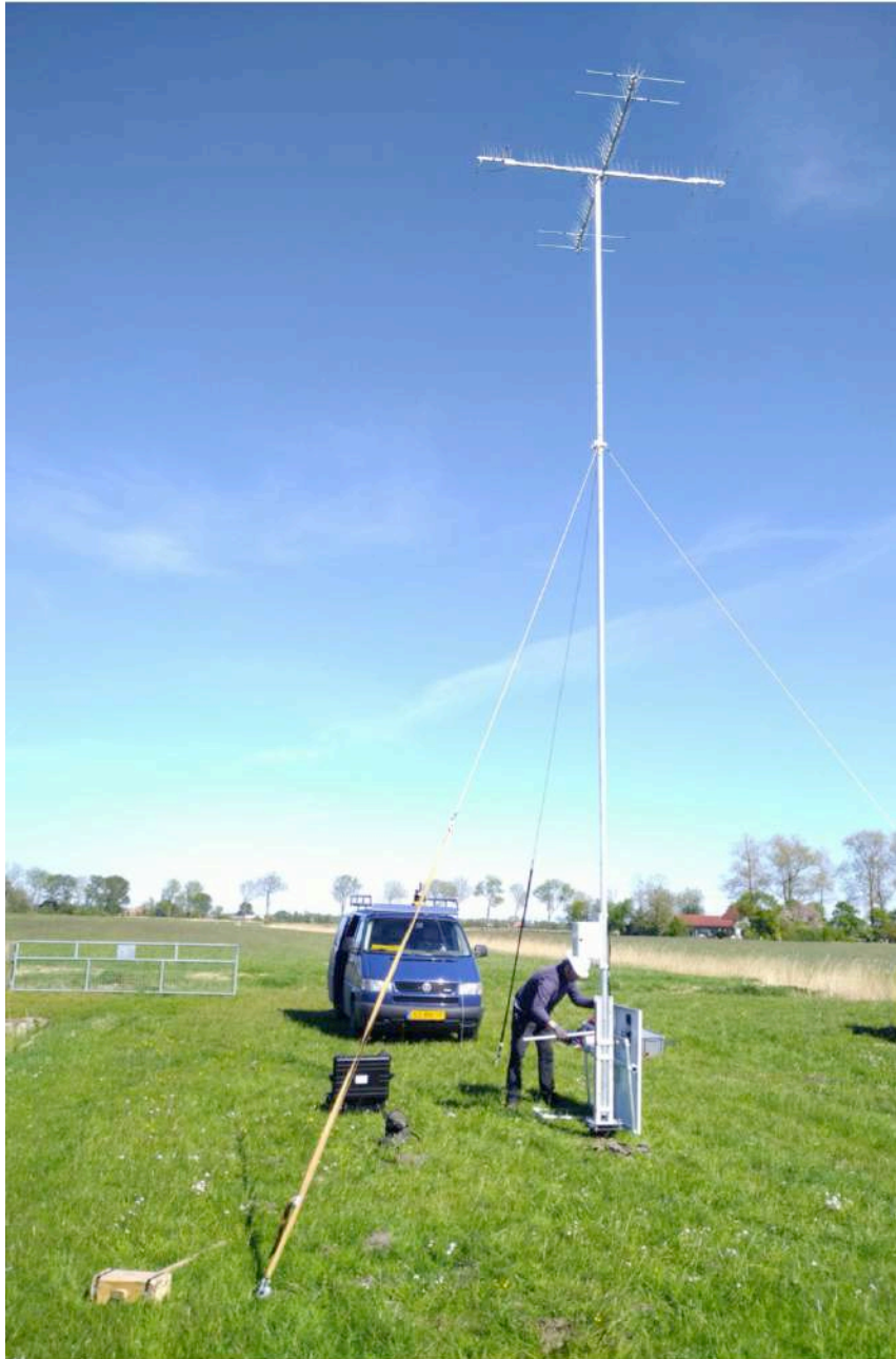
Figuur 3.3 Plaatsing van een antennemast van 9 meter hoogte voor automatische radiotelemetrie van kuikens
