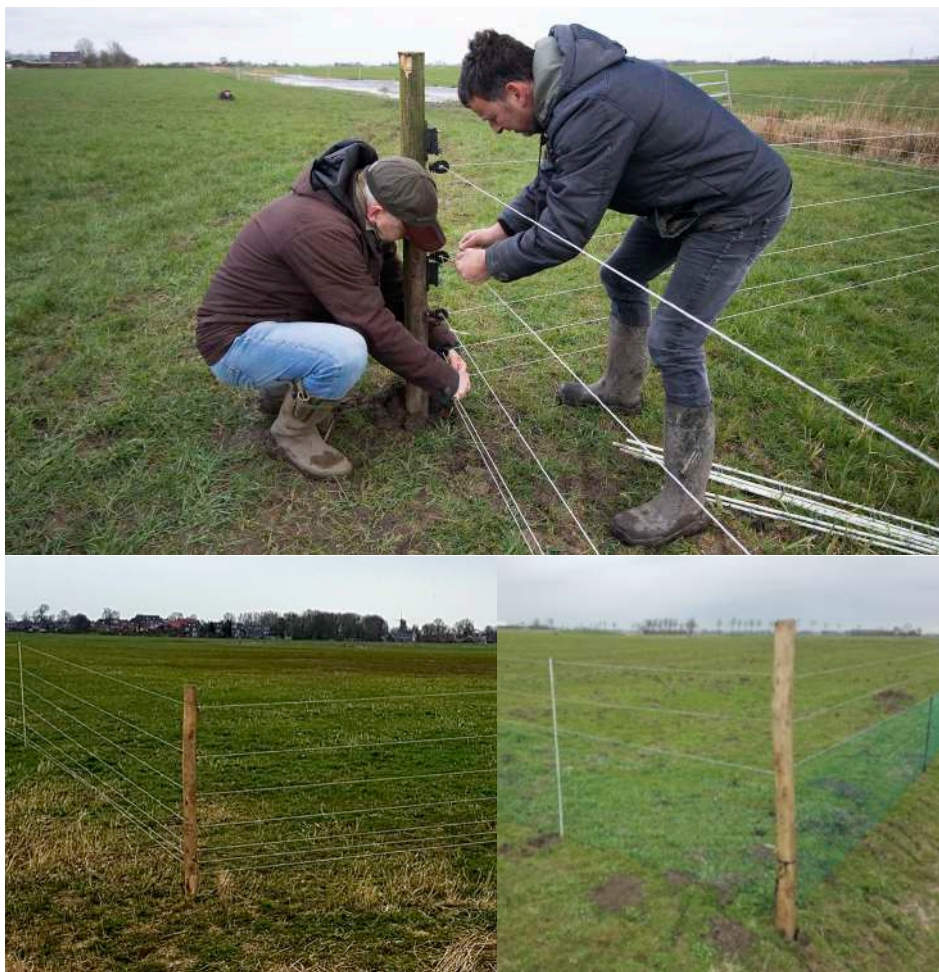
Figuur 2.7 De stroomrasters in de Winsumermeeden en in het centrale deel van Paddepoel. Het raster in de Winsumermeeden bestaat uit 5 draden (bovenste foto). In Paddepoel heeft het raster 7 draden en is deels aan de onderkant voorzien van konijnengaas (onderste foto's).
