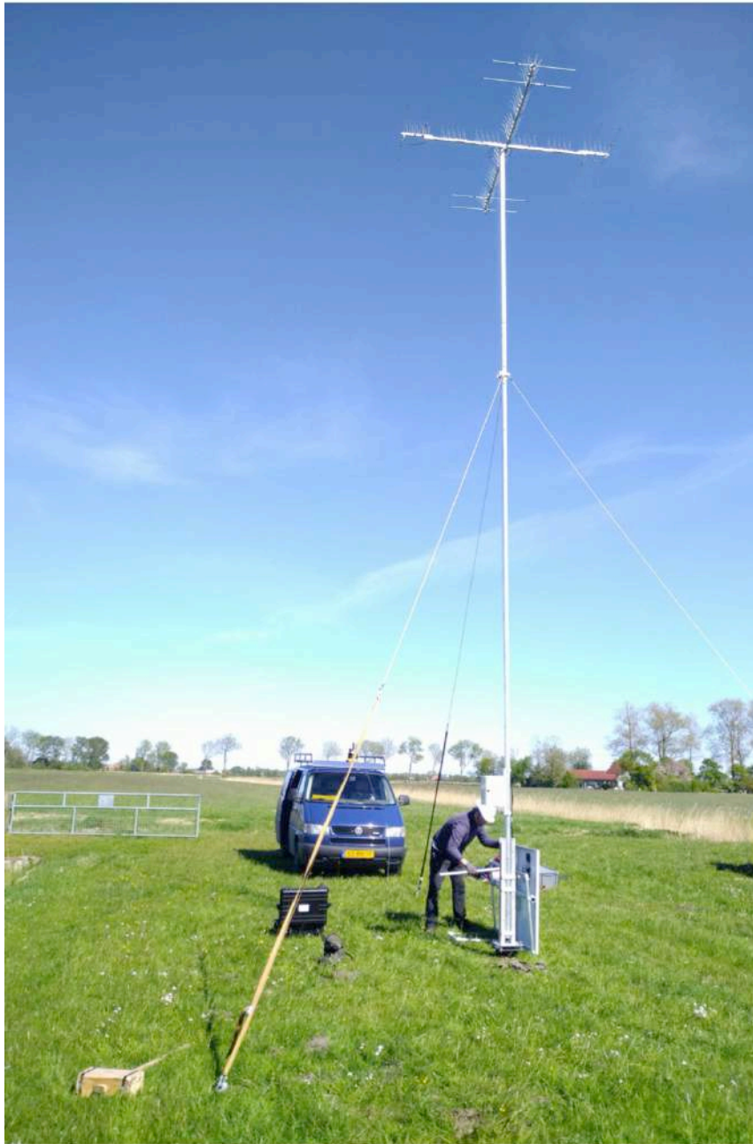
Figuur 3.2 Plaatsing van een antennemast van 9 meter hoogte voor automatische telemetrie
